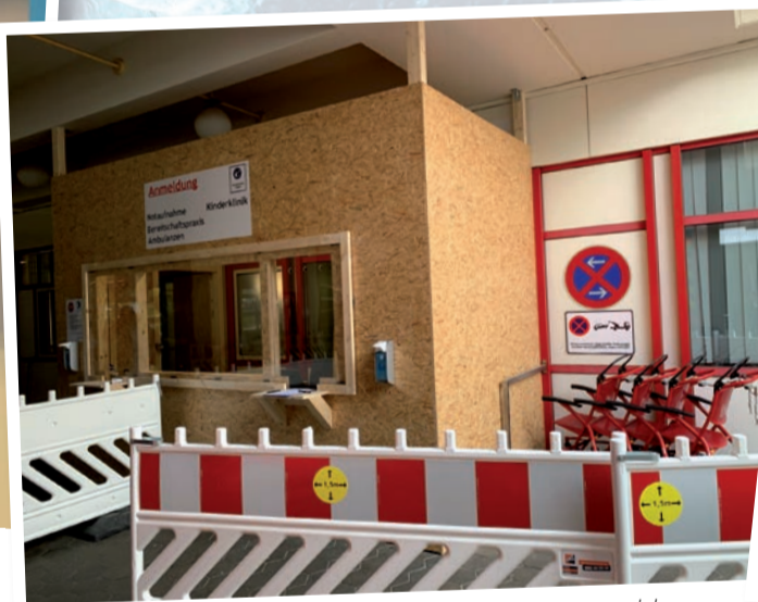
Die Abteilung Bau & Technik baute eine neue Anmeldung...
